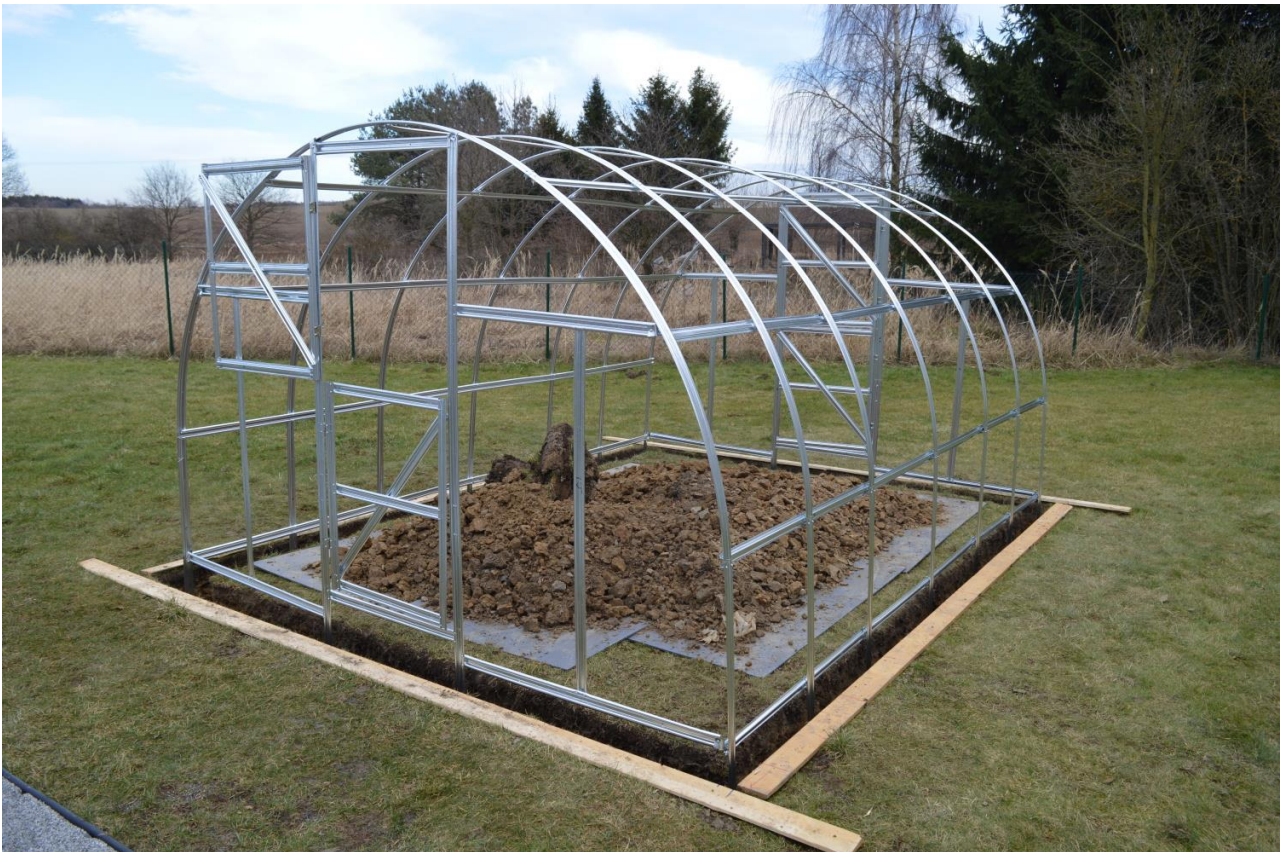
Ilustračný obrázok ukotvenia konštrukcie skleníčka Kyklop (modelový rok 2017) do krajiny (Jednotlivé profily sa môžu svojou polohou odlišovať v závislosti od modelu, rozmeru a na roku výroby skleníčka) princíp ukotvenie do zeme je zhodný u všetkých modelov rady Kyklop
