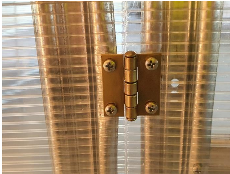
detail primontovaný pántov z vonkajšej strany skleníka aj polykarbonátu
