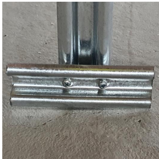
detail G (pohľad zvnútra skleníku)
